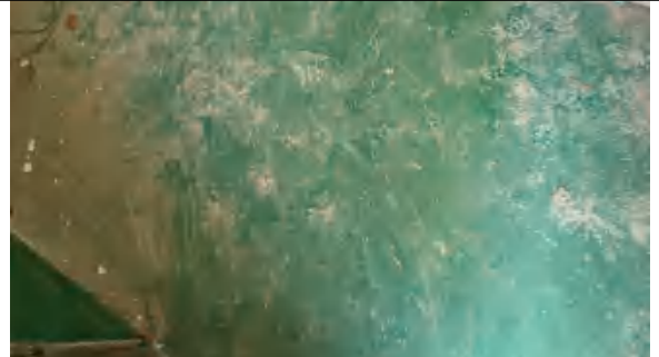
图 3-10 危废仓库地面
