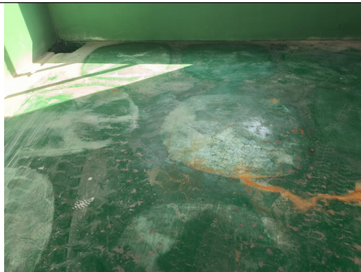
图 3-10 危废仓库地面
