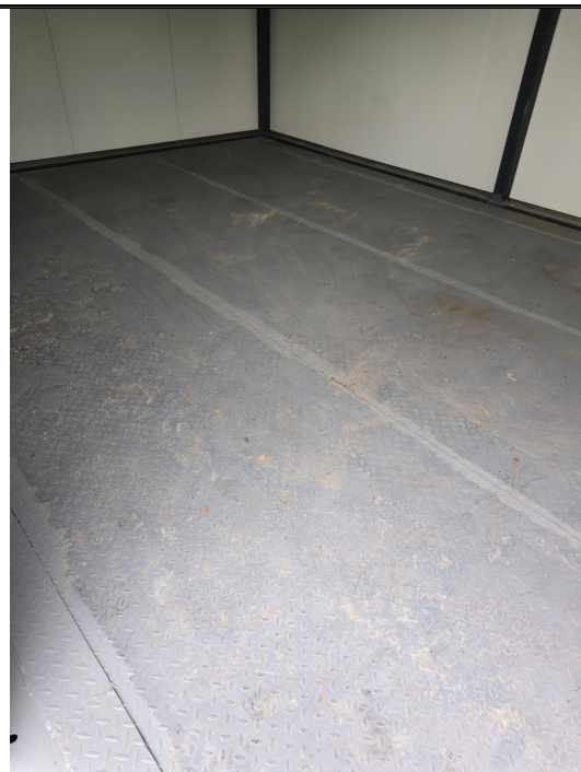
图 3-10 危废仓库地面
